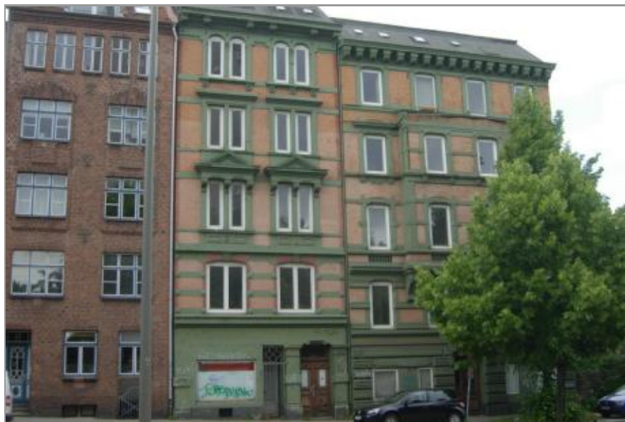
An der Breiten Straße 112-116 stehen seit Jahren drei Häuser aus der Gründerzeit leer Foto: Dörte Schmidt-Reichard
